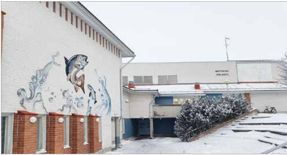
Nykyinen Nätteporissa sijaitseva kirjasto on kodikas, näymät ikkunoista joelle ovat henkeäsalpaavan kauniita ja palvelu aivan yhtä miellyttävää kuin ennenkin. Harmi, että rakennus on niin huonos- sa kunnossa, että se joudutaan purkamaan. (Kuva Jenny Kärki)
