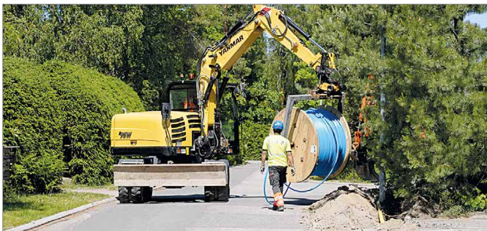
Valoon valokuituliittymiä rakentavat paikalliset urakoitsijat. Kuva Valoo Oy
