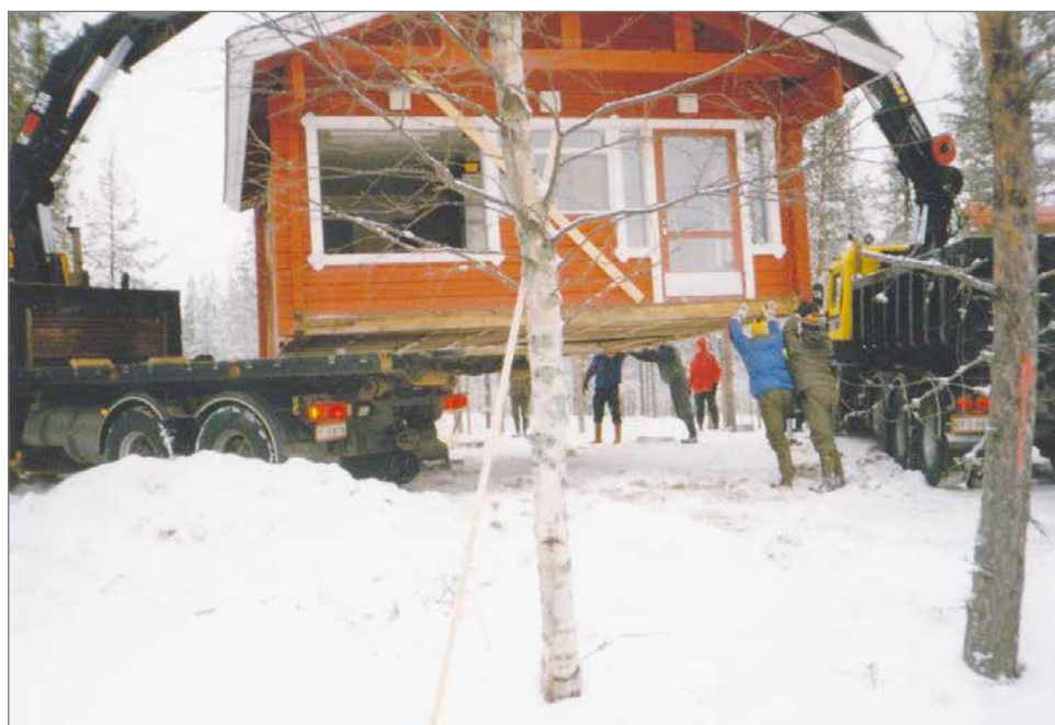
Kurenalta löytyi tyhjillään ollut hirsinen "Mummarin kiosk", joka lavetilla tuotiin nykyiselle paikalleen Sotkajärvelle. Kioski toimii edelleen varastona lounaskahvilan pihapiiristä. Kuva Tulitauon arkistosta.
