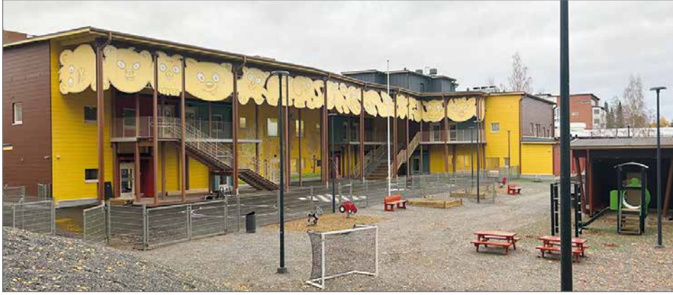
Kontion hirrestä valmistettu Sinikellon päiväkotikontti tarjoaa nyt tilat yli 200 kuopiolaiselle lapselle sekä henkilökunnalle. Kuva Erkki Hakkarainen
