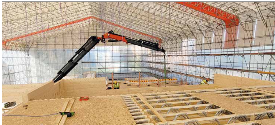
Kohde asennettiin suuren sääsuojan sisällä, kuten nykyään on tapana ja esimerkiksi hirsirekat pystyvät ajamaan ja purkamaan kuormat suoraan sääsuojan sisälle. Kuva: Kontio
