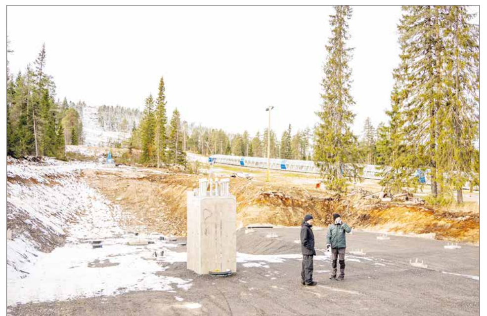
Ala-aseman tieltä kaivettiin valtava määrä maata. Suunnitteen Mikko Törmälän ja Mikko Terentjeffin kohdalle tulee hissin alakääntöpyörä.
