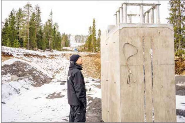
Hissipylväiden perustusten tekeminen on millimetrityötä. Mikko Törmälä tuolihissin ala-asemalla.
