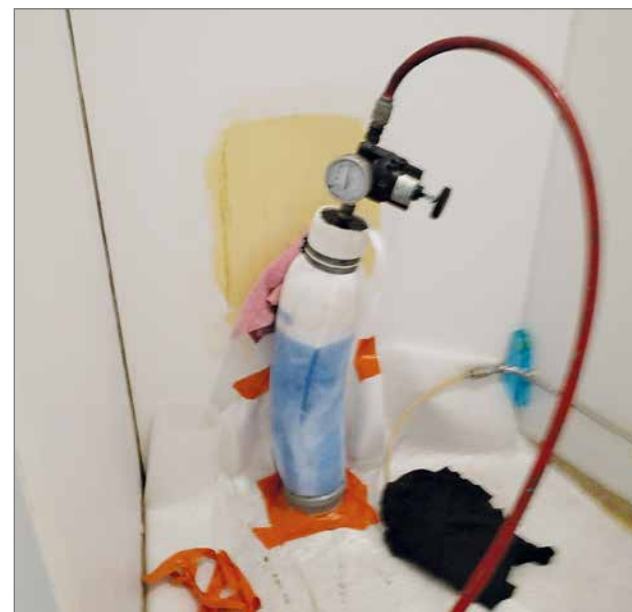
Teemu Kitunen Lvi-Fenix Oy:stä kertoo sukan sisälle laitettavan epoksihartsiseoksen, jonka jälkeen sukka mankeloidaan haluttuun vahvuuteen ja sukka laitetaan paineilman avulla viemäriputkeen.
