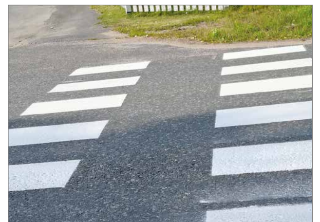
Kausiluontoisiin kunnostustöihin kuului muun muassa suojaiteiden maalausta. Kuva Kaisu Heikkinen
