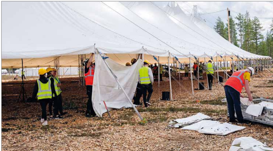
Ison seurateltan perustusten teko aloitettiin viime syksyn puolella ja juhannuksen jälkeisenä maanantaina teltta oli kohonnut koko komeuteensa. Kuvapalvelu/Suviseurat
