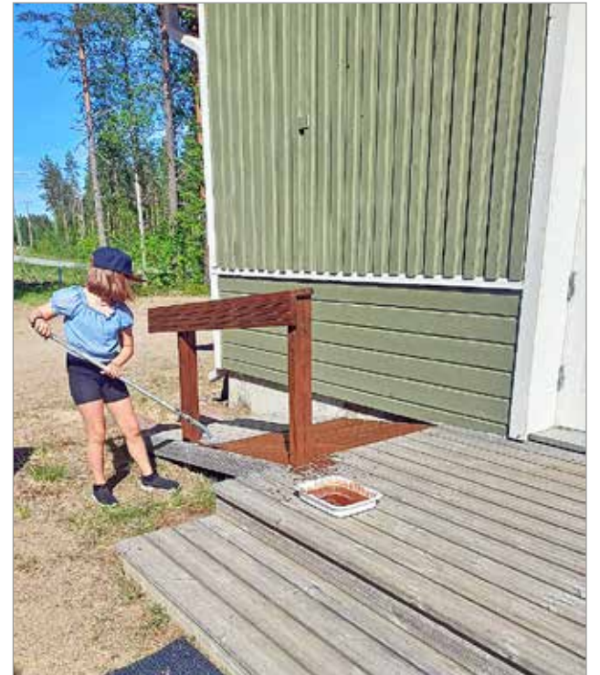
Maamiesseuran talolla tehdään pieniä kunnostustöitä pitkin vuotta. Pihatalkoiden jälkeen Miia Pakonen öljysi kesätöinä talon portaat sekä liiterin terrassin. (Kuva Kirsimaria Pakonen)
