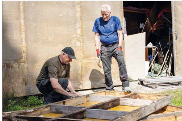
Sami Manninen ja Raimo Moilanen rakentavat ulkolavan lattiaraakenteet kestävämpään rokkibändin temmellyksen.
